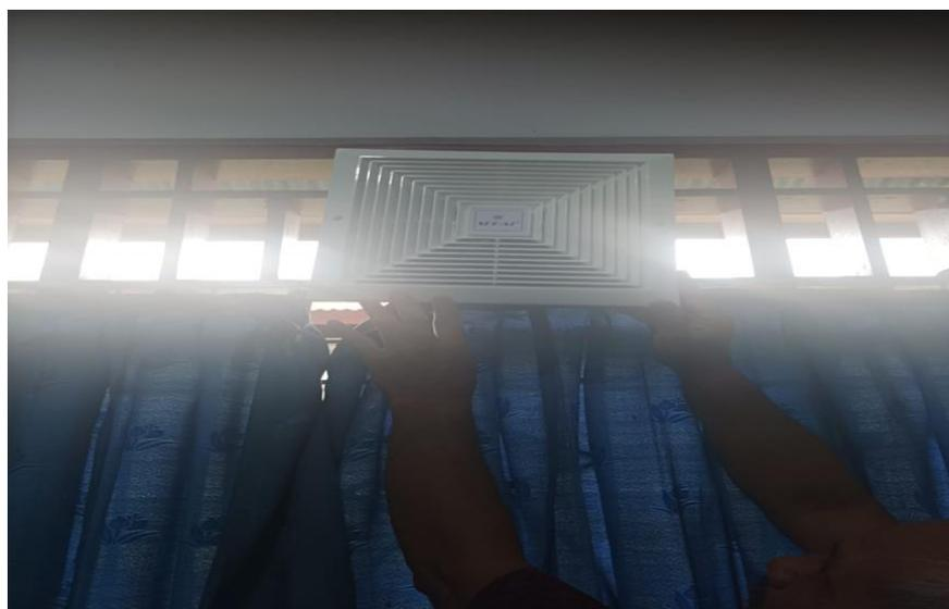
Gambar 5. Pemasangan *blower/exhaust fan* (pengisap udara dari dalam keluar ruangan laboratorium tempat menyimpan bahan kimia
